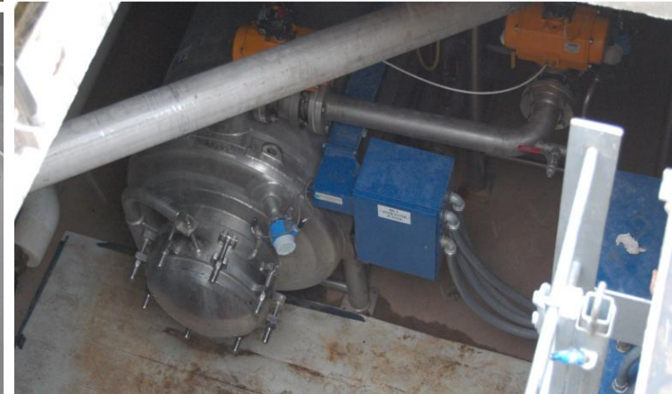
Liquid effluent decon pump
