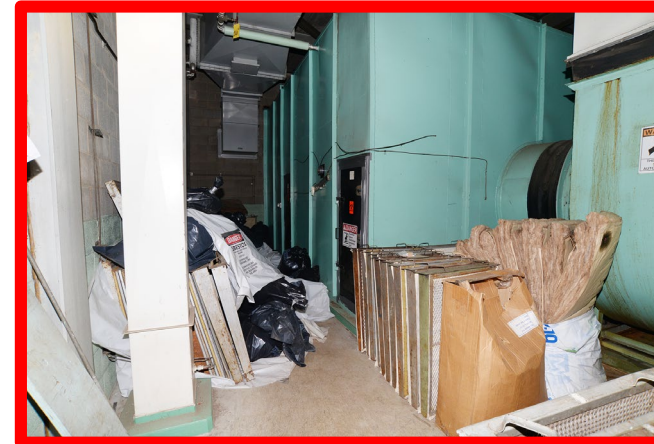
Exhaust Fan Room
